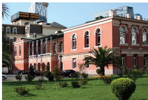
Gürcüstan Konstitusiya Məhkəməsinin binası, Batumi
